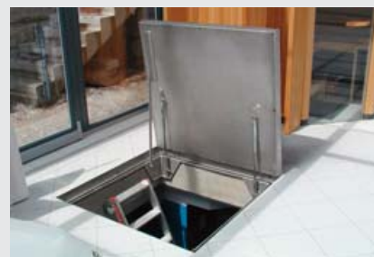
Пример: установленные напольные люки
