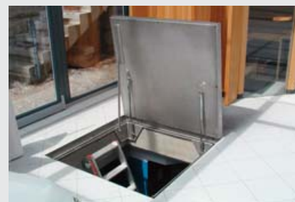
Παραδείγματα: τοποθετημένες επικάλυψεις φρεατίων
